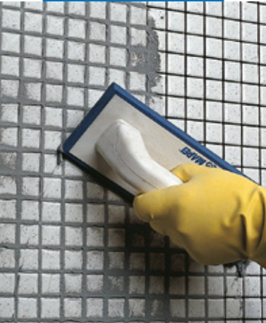
Stuccatura di rivestimento in mosaico vetroso (in bagno) con spatola
