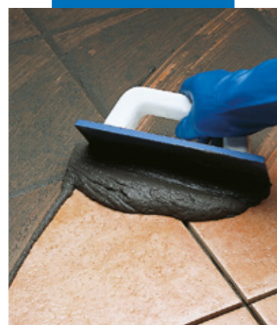
Stuccatura di monocottura con spatola
